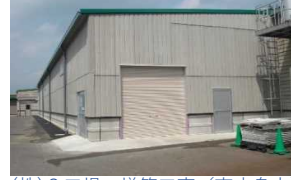
(株)S工場 増築工事 (東広島市)
