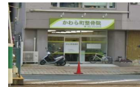
かわら町整骨院 改修工事 (中区)
