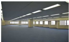
Kビル内部改修工事 (中区)
