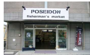
ポセイドン改修工事 (呉市)
