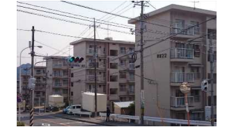
県営住宅内部劣化点検業務 (広島県内)
