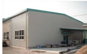
S精機工場増築工事 (安芸高田市)
