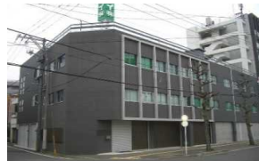
S(株)外壁明装工事 (中区)
