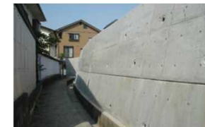
T邸 擁壁補強工事 (安芸区)
