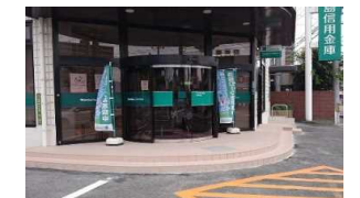
広島信用金庫 玄関ポーチ改修工事 (安芸区)
