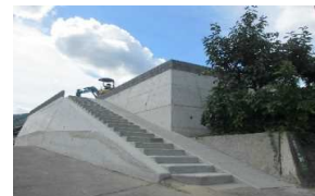
N邸擁壁補強工事 (安佐南区)
