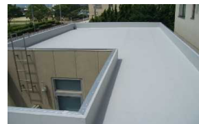
Nビル屋上防水改修工事 (南区)
