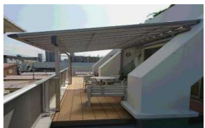
H本社屋上ウッドデッキ取付工事 (南区)
