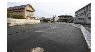
K管財駐車場整備工事 (安佐南区)
