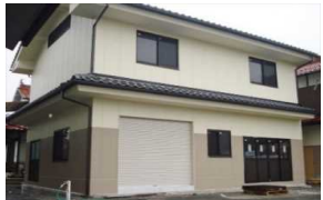
M製畳所新築工事 (東広島市)
