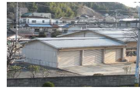
広島県K検査場施設 改修工事 (南区)
