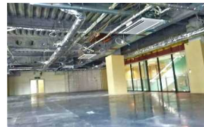
Kビル4階内部解体工事 (中区)
