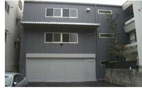
S(株)倉庫 新築工事 (中区)
