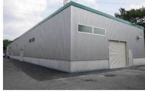
(株)S豊栄工場新築工事 (東広島)
