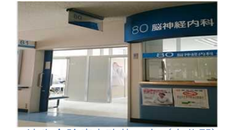
済生会診療室改装工事 (安芸郡)
