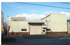
Y倉庫改修工事 (安佐南区)
