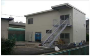
K弁当センター新築工事 (安芸郡)
