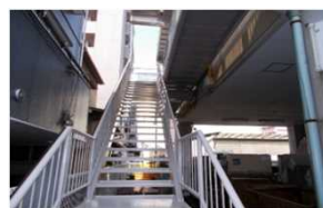
(株)J P 屋外階段設置工事 (南区)
