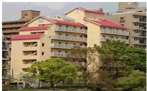
E大学寮外壁明装工事 (中区)
