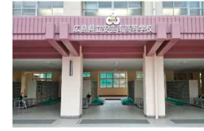
広島県立A高等学校玄関明装工事 (安芸区)
