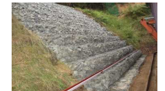
(株)S 法面改修工事 (東広島市)
